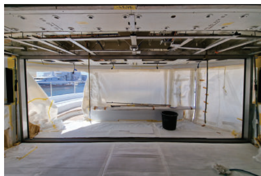
Baie coulissante 2 et 3 rails associés avec 6 vantaux dont 2 parties fixes latérales de refoulement des ouvrants.
