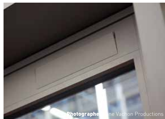
Trappe d'accès pour maintenance
