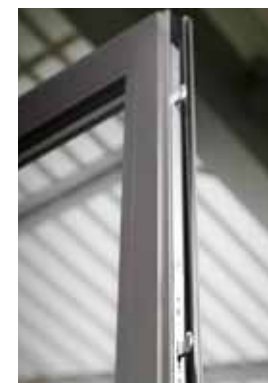
Points de verrouillage avec tête inox
