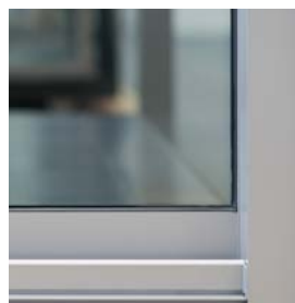
Détail extérieur du châssis : dormant-traverse basse
