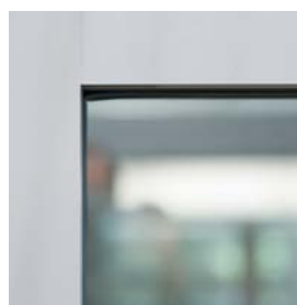
Détail du châssis : dormant-ouvrant
